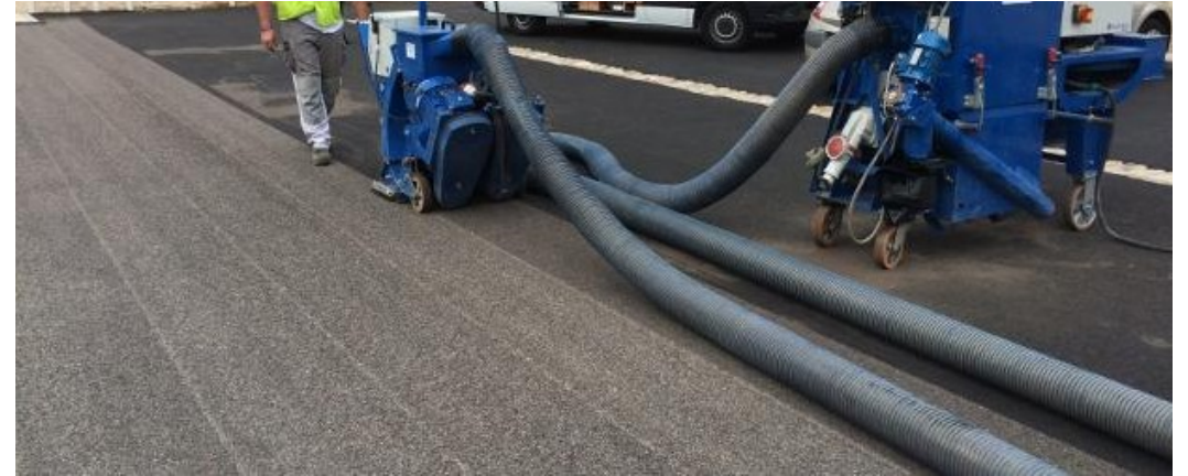
Grenailage des enrobés
